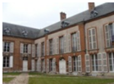
Le bâti ancien
